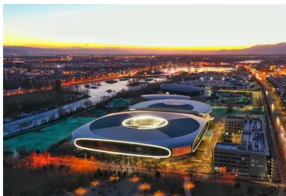
北京冰上项目训练基地
